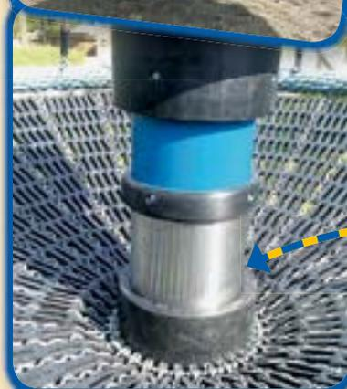
VA-Mastschutz zwischen Mast und Laufbuchse.
